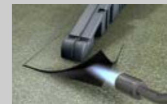
2- Soudage en plein des plots à la flamme.
