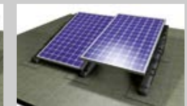
4- Pose des modules, des étriers et raccordement électrique à l'avancement.
