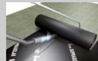
1- Mise en œuvre de l'étanchéité SOPREMA sous AT sur isolant de classe C ou supérieur.
