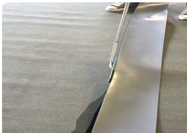
Prenoflex DBE beim aufschweissen auf Polymerbitumen-Dichtungsbahn
