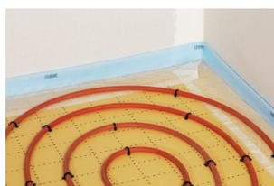
Isolant sous plancher hydraulique
