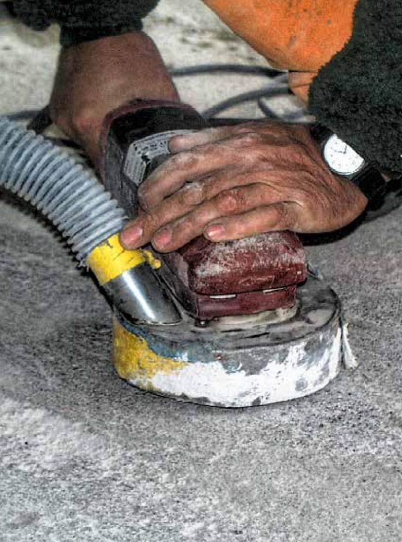
Händisches Nacharbeiten mit kleinem Rotoschleifer
