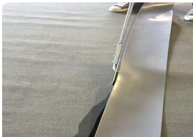
Prenoflex saldatura DBE su membrana in bitume polimero
