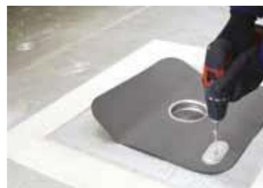
La membrane de partie courante est soudée sur une largeur de 3 cm minimum entre le sertissage et les fixations mises en œuvre de la platine de la naissance DRAINI FLAG PVC.
