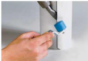
Couper une bande de membrane souple non armée de **FLAGON® S 15/10** avec un excédent de 3 cm pour la soudure verticale, comme indiqué sur la photo
