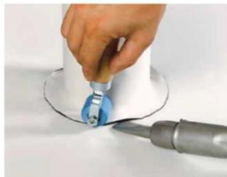
Réintroduire le cylindre et souder à la surface horizontale.
