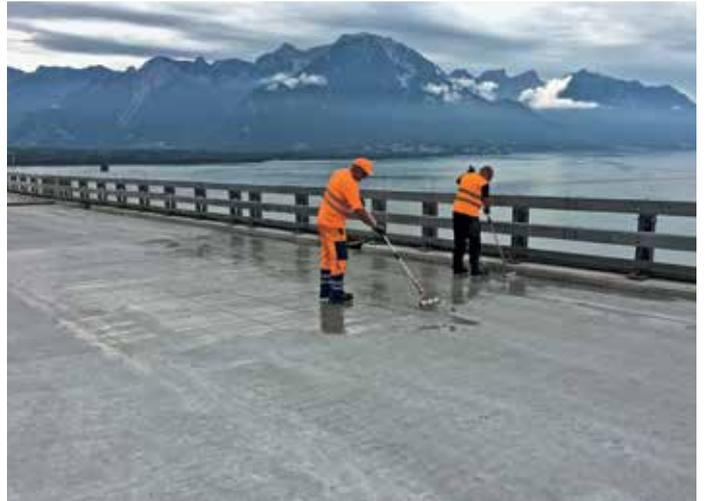
Il sigillante Reku è un sistema omologato secondo le norme SNV 640450, ZTV ING; RVS ed EN 14695 utilizzato per la realizzazione di sigillature a base di PMMA su ponti e tetti di parcheggi.
