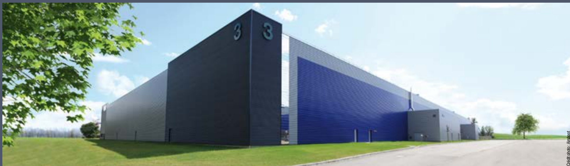
Pôle logistique, Strasbourg - Maître d'oeuvre : LCR - Maître d'ouvrage : LCR
