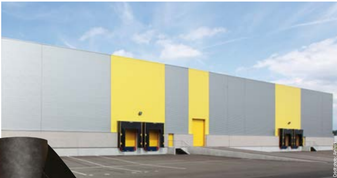
De Rijke, Herrlisheim - Maître d'oeuvre : SOCOBAT - Maître d'ouvrage: SCI Florwel S/C Spiral
