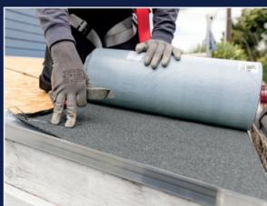
1 Positionner le rouleau parallèlement à la ligne d'égout et le couper à la dimension.
