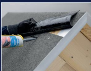
5 Dans le cas d'une couverture à 2 pans, un lé est positionné à cheval pour créer la faîtière de finition. Vous pouvez dérouler sur la longueur et plier au milieu. Ne pas clouer ce lé mais, après avoir enlevé le film détachable, renforcer l'adhésion de la feuille avec la Colle Bardeau SOPREMA.
