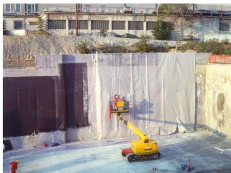
La membrana FLAGON PVC PZ può essere utilizzata nell'ambito di sistemi impermeabilizzanti monostrato, compartimentati o no, e nei sistemi Vacuum Flag.
