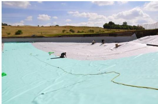
Geralmente, as soldaduras entre membranas são realizadas com ar quente ou com cunha quente, com um dispositivo de soldadura manual ou automático. Também podem ser realizadas com soldadura única ou soldadura dupla com um canal central, permitindo uma verificação com ar comprimido.
