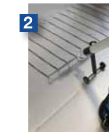
De lijm wordt in evenwijdige stroken aangebracht door middel van een speciaal hiervoor ontwikkeld accu-lijmpistool en bijbehorende lijmgeleider.
