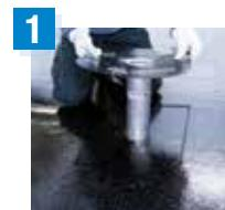
Plaats de Draini in de opening na het aanbrengen van de eerste waterdichtingslaag.
