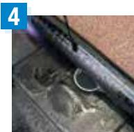
Las de tweede waterdichtingslaag en bedek daarbij de volledige afloop.
