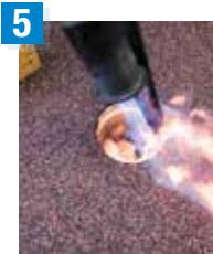
Laat deze toplaag even afkoelen en snij daarna zorgvuldig de opening van de hemelwaterafvoer uit.
